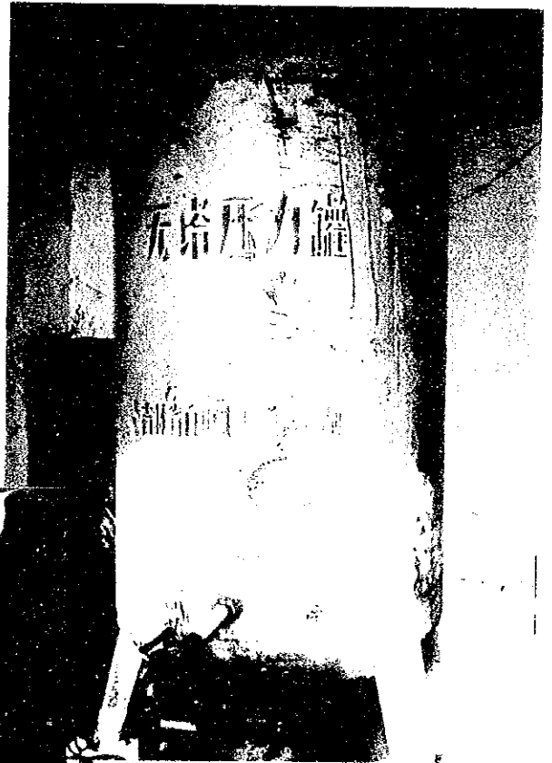
既存井戸 圧力タンク
