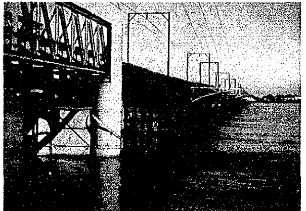
写真-8 鉄道橋 (右岸側より望む)
