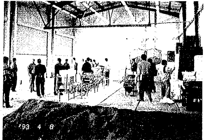
▲ プロジェクト基盤整備により建設した機材庫及び供与機材
