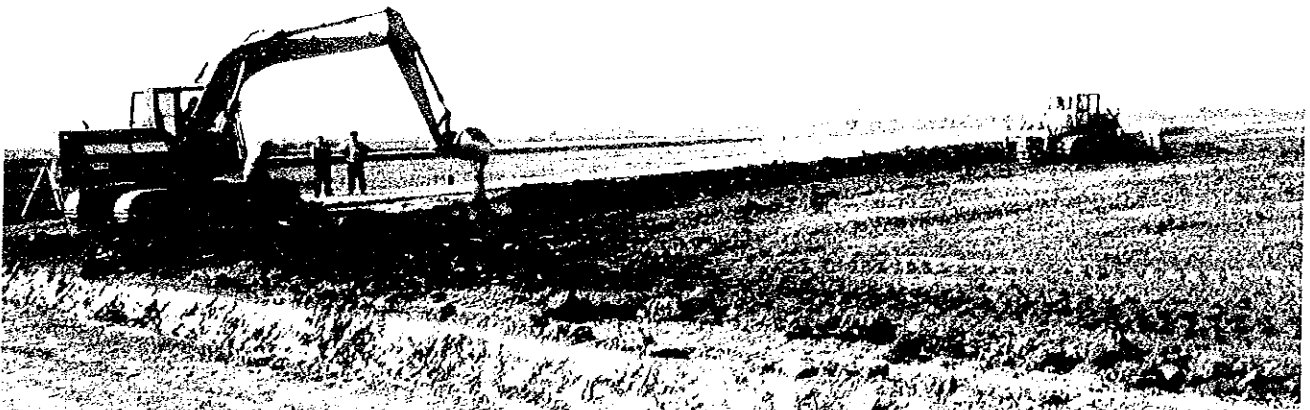
▲ Eslam Abad パイロットファーム圃場整備
