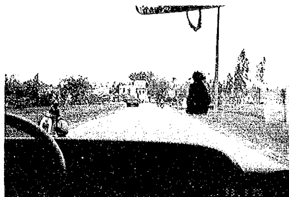
5号国道。2車線部。
