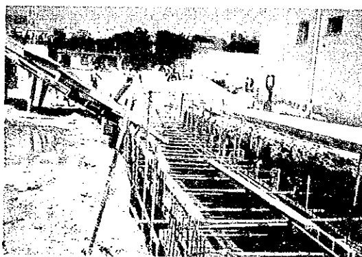
スース圏スース市内で行われている、ボックスカルバート方式による雨水排水施設の建設工事。
