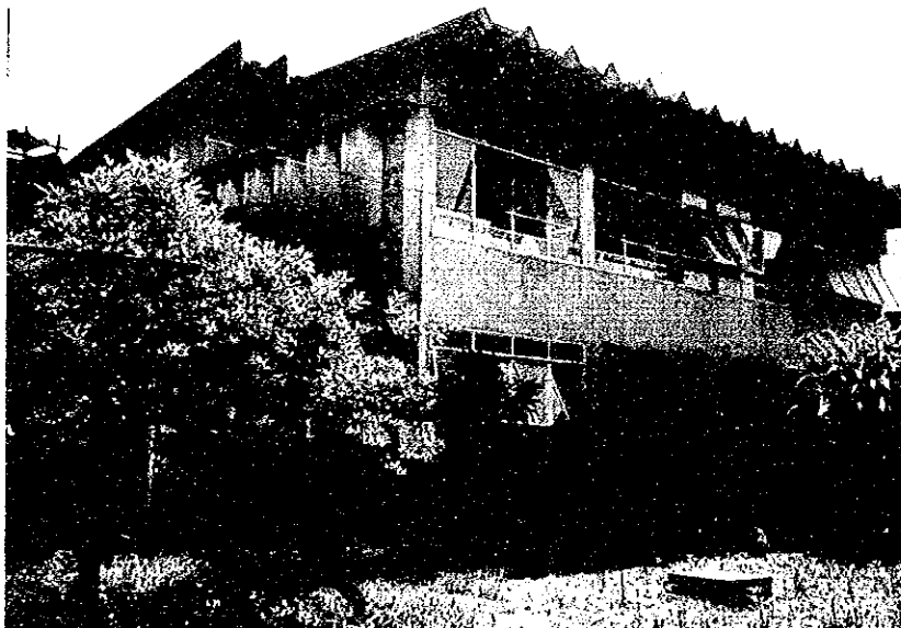
写真2 IPT・火災試験室・実験棟
