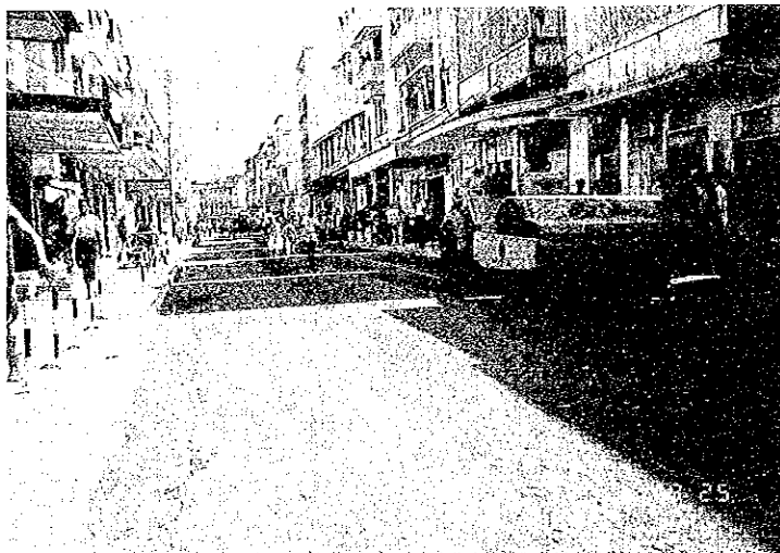
ダレスサラーム市内の 道路リハビリ工事視察 (タンザニア、日本の無償資金協力)
