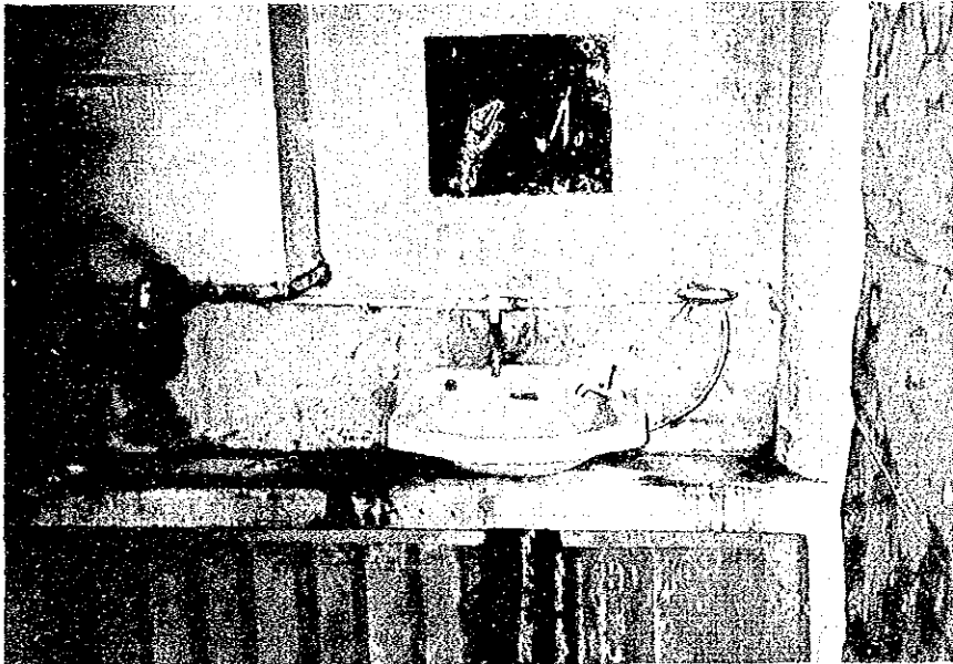
各戸水栓（簡易貯水槽を備える）
