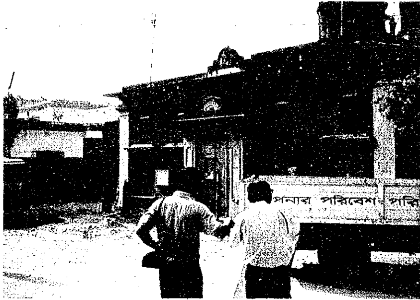
1937年に建設された給水施設 (現在は使用されていない)
