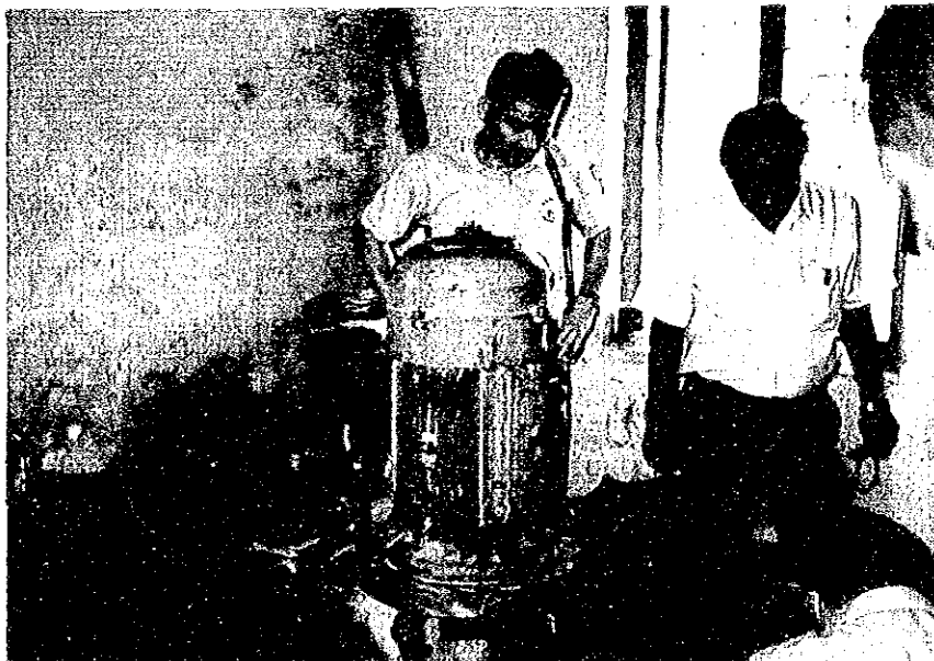
地下水揚水ポンプ（パキスタン製）
