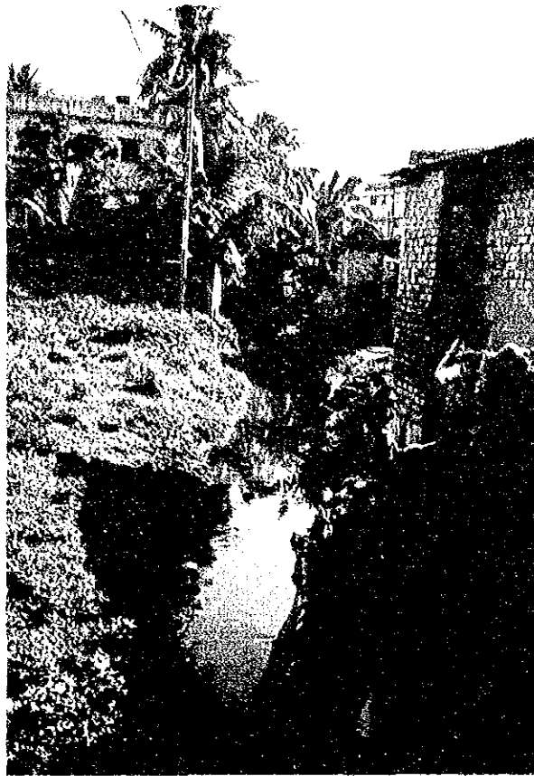
ラジシャヒ市内の排水路
