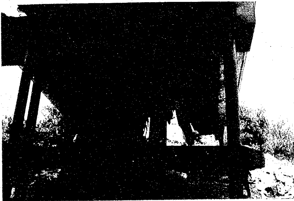
橋脚破壊による落橋
