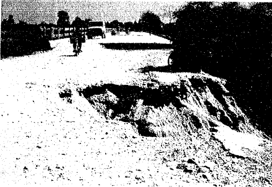
橋台付近における局所的な盛土の流出
