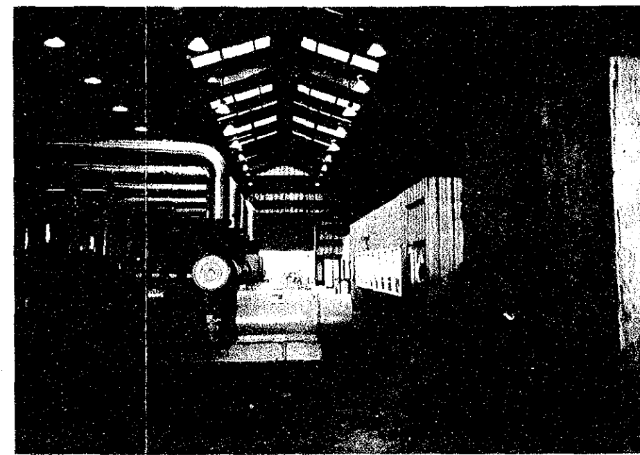
同上発電設備
