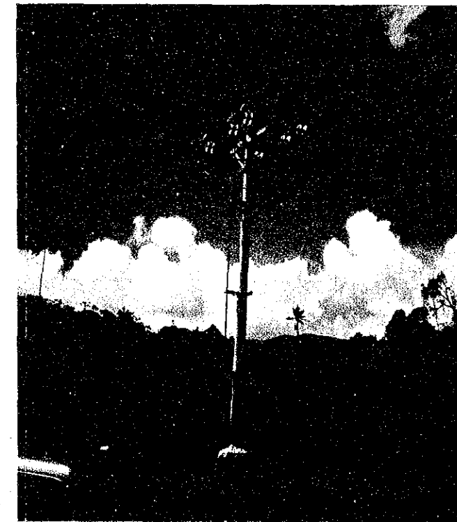
島南部の架空線とコンクリートポール 島南部の電化は1990年1月
