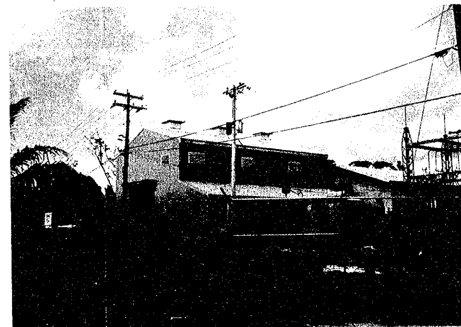
工事中の発電機建屋の南側立面計画建屋は写真左手(西側)に隣接して建設される。計画変電施設は、既設に隣接して計画建屋の正面に設置予定。
