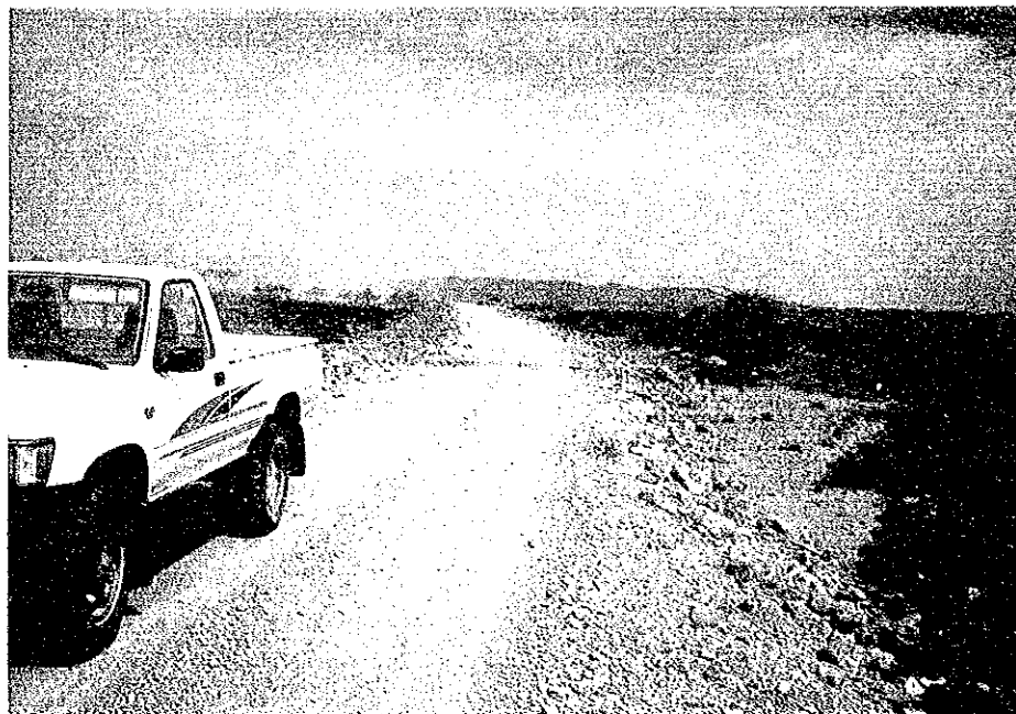
日本の無償資金協力による建設機材で改良された砂利道 (国道RN5, 1988-89)
