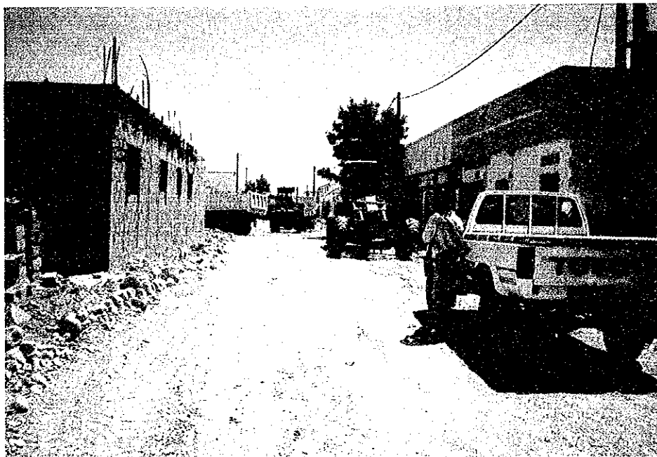
市街道路の整備
