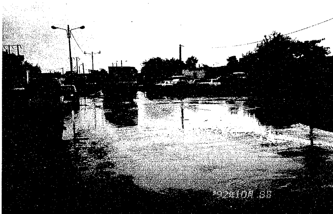
ジブチ市内の主要道路 (雨のあとの路面、排水処理が不十分)
