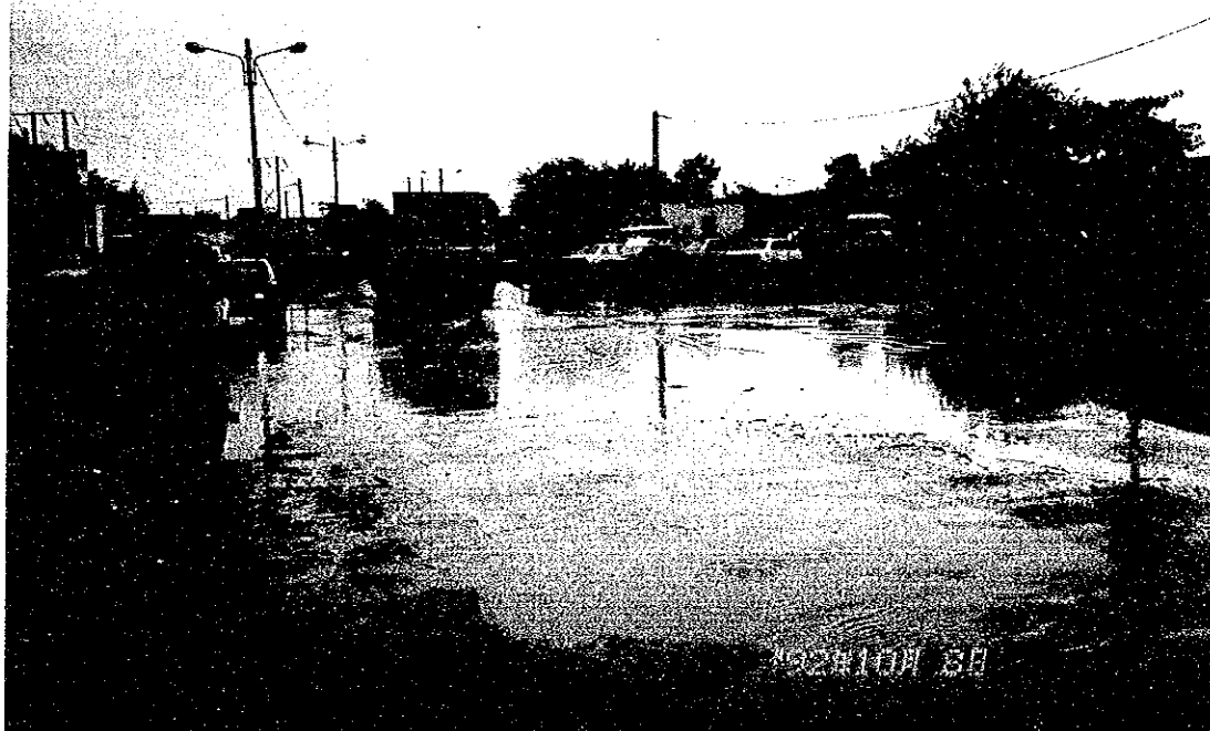
Route principale dans la ville de Djibouti (Après la pluie, manque du système d'évacuation d'eau)
