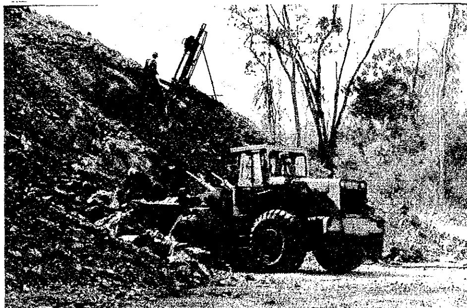
ラオ村附近砕石用原石山作業現況
