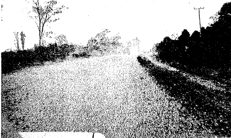
アスファルト表層処理工事（2層簡易舗装）
