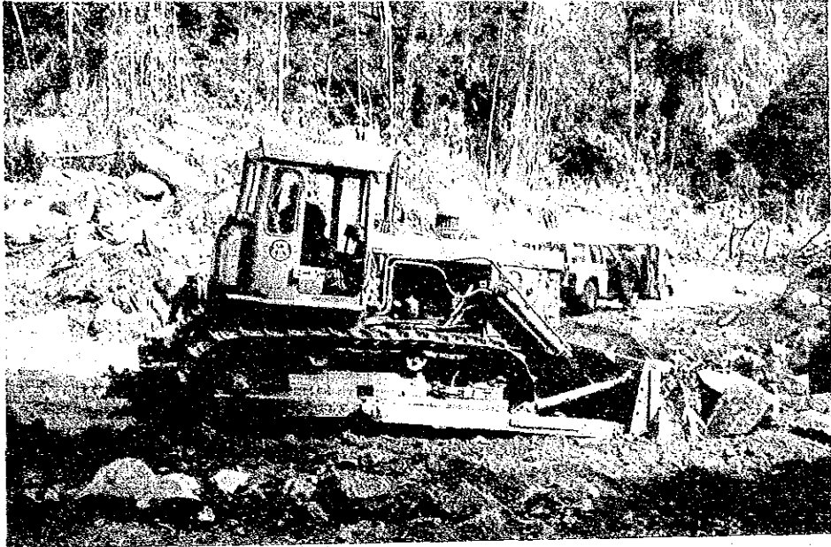
ブルドーザーによる転石混じり土の排土作業、測点 km34+500
