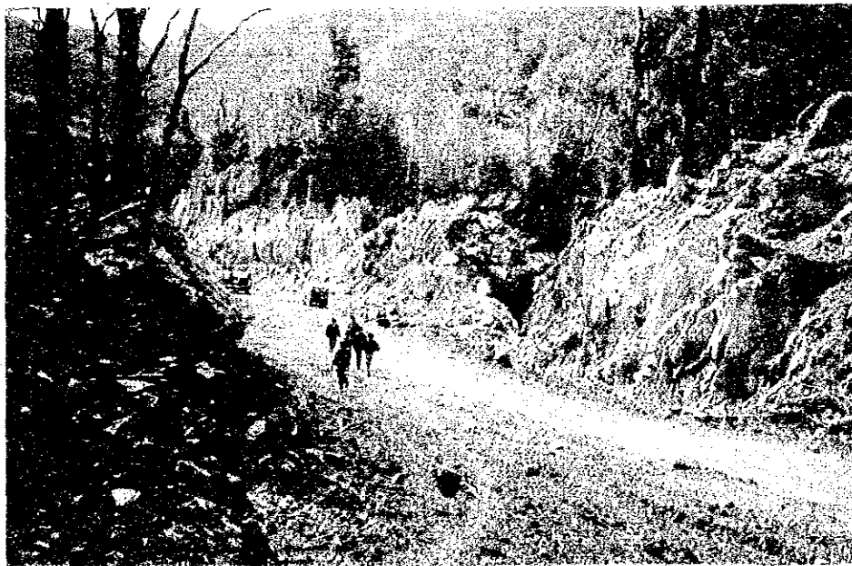
山間部最難施工区間硬岩掘削状況 測点 km35
