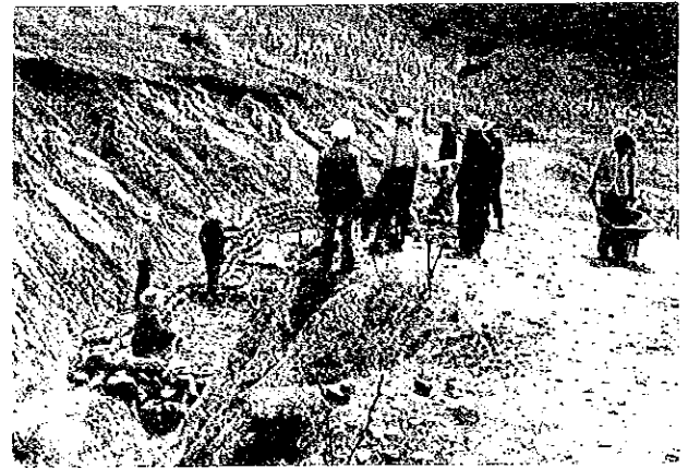
施工中の治山施設
