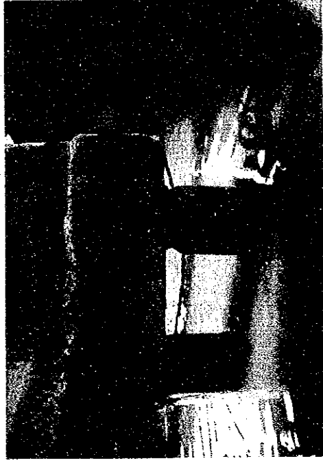
写真5-4 フーチングの鉄筋露出、杭 (8角形、径35cm) 頭部クラック。 パースNo.4, BENT 13, Row A
