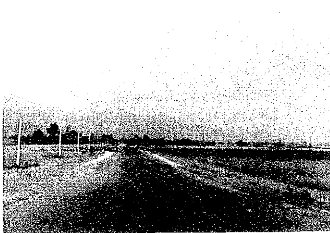
▲ マヘンドラ道路（ヘタウダ～バラトプール間）
