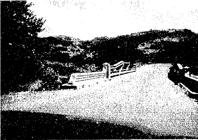
▲ 3号線 (マタガルバ西の橋梁)
