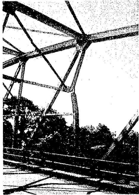
▲ 2号線上の破損橋梁
