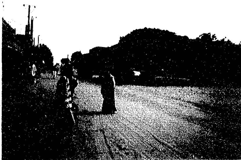
グラン・ヨフ浸水被害発生地区
