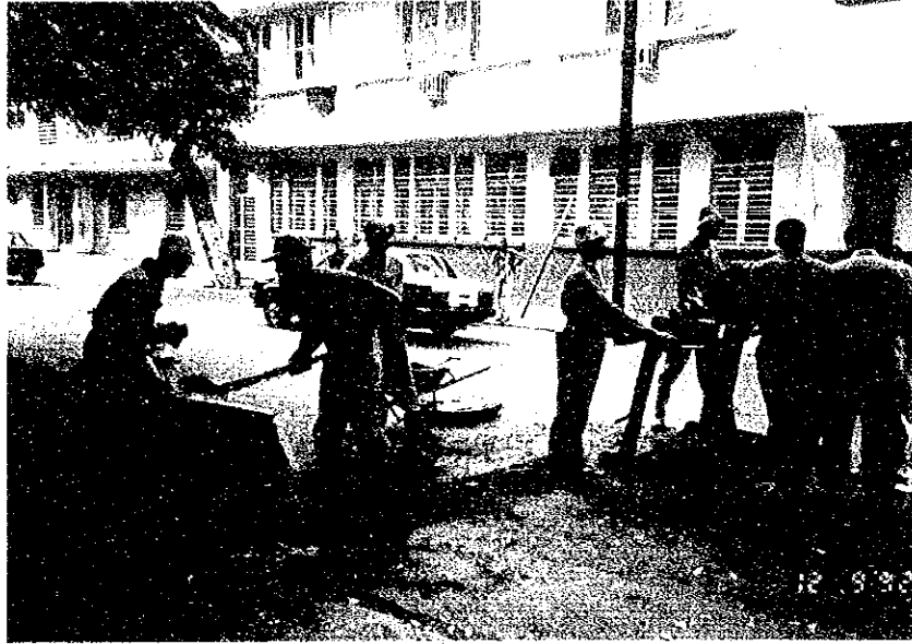
下水管渠浚渫作業
