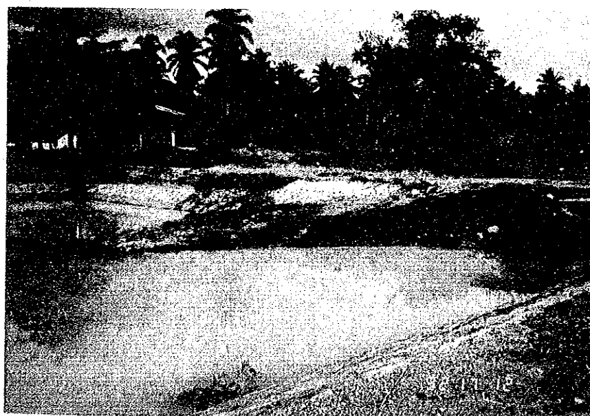
シルトに埋没したま まのSlow Sand Filter
