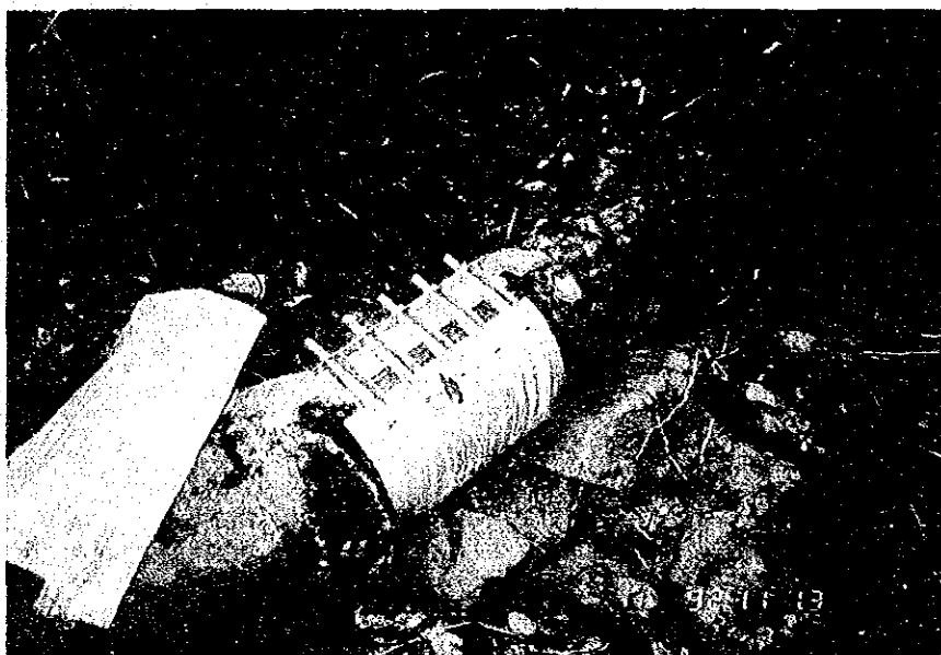
土石流による送水管 の露出・腐食が進み 漏水の応急措置。
