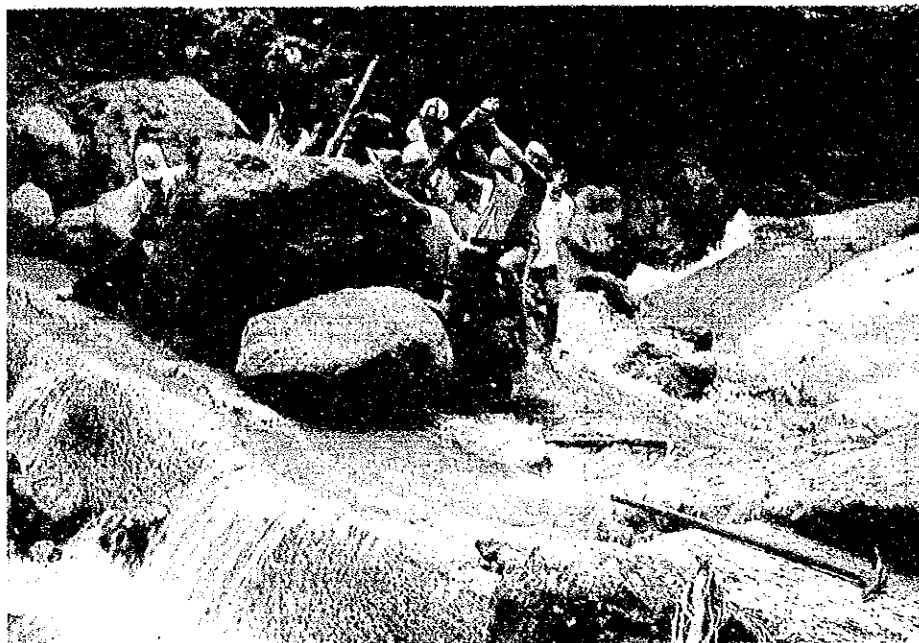
落石により損壊した HiLognob Dam、及び 人力による落石の撤 去作業。
