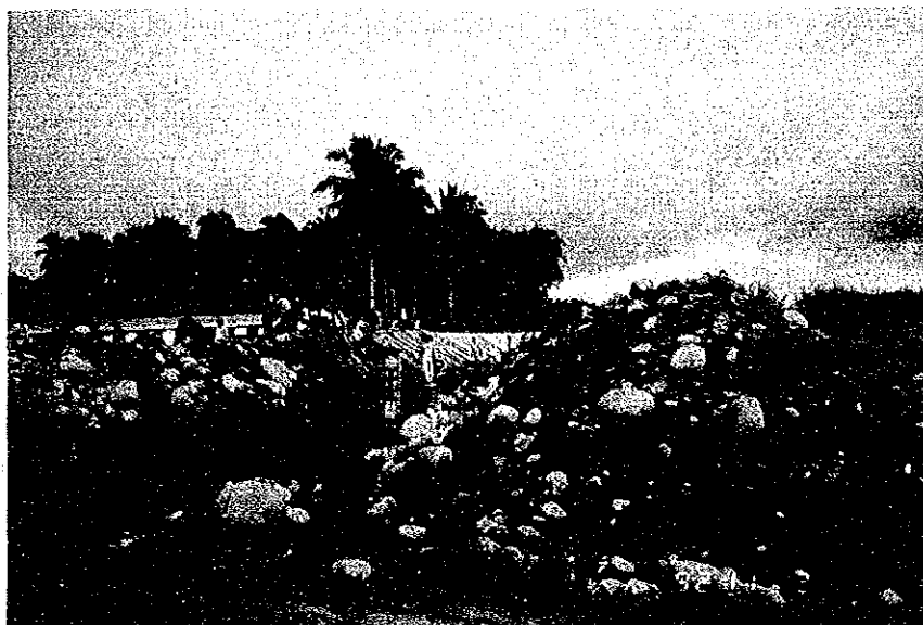
Tingib処理場近辺の護岸作業。但し恒久的なものではなく、台風シーズンに備えての応急処置。恒久的なストラクチャーが望まれている。
