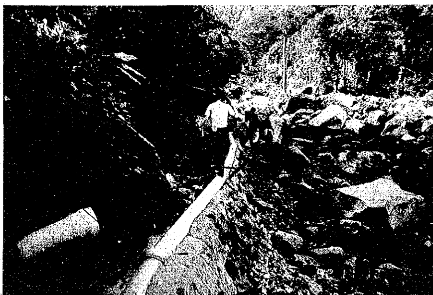
同上仮設の取水口に 接続された仮設配管 (PVC250mm)
