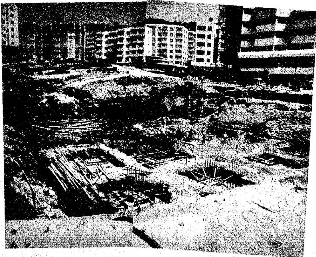
▲ プロジェクトサイト (教育棟基礎工事、実習棟は前方建物の後方の予定)
