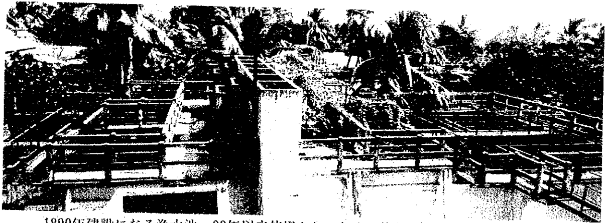
1890年建設になる浄水池。83年以来使用されてなく、施設の傷みが激しい。
