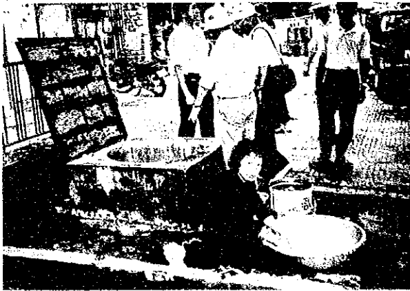
低水圧地区の受水ピット (1) バケツで汲上げ飲料用や洗濯などに供している。水位が低くなるとピットへの地下水の侵入が危惧される。
