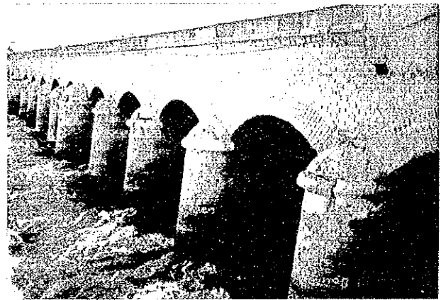
マズラ レギュレーター (ダイリュート堰から230km)
