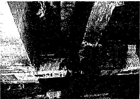
▲ NOGARES橋 ヒンジ部、鉄板等による補強
