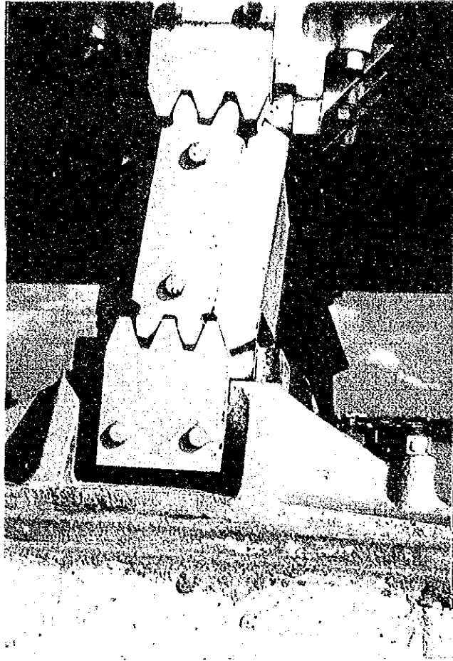
写真-3-15 P7橋脚ロッカー支承の状況
