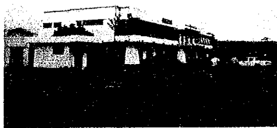
写真—15 トビアス・ボラニャス空港 ターミナル
