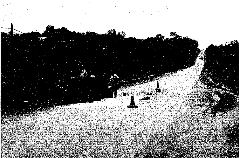
カンバラ市内道路 日常維持管理業務/ DBSTによるパッチング作業
