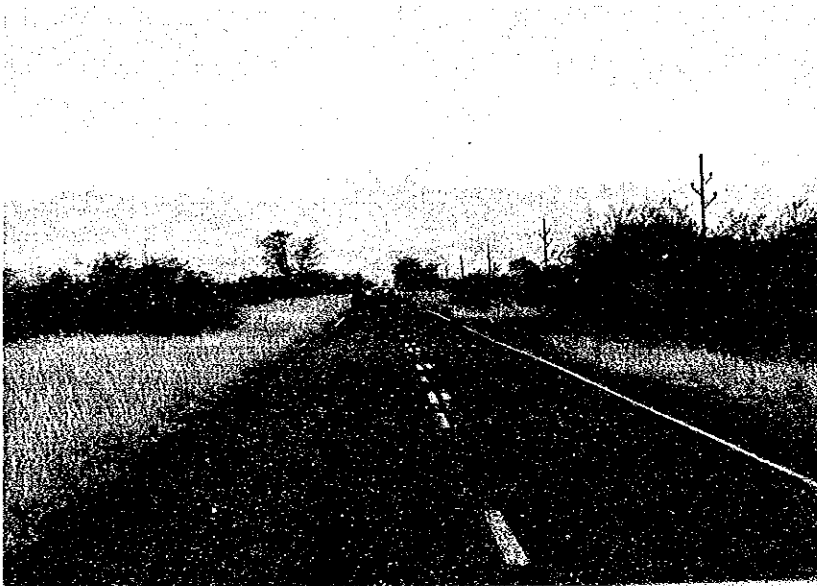
ムバララーフォートポータル国道 イシヤカーカツングル区間
