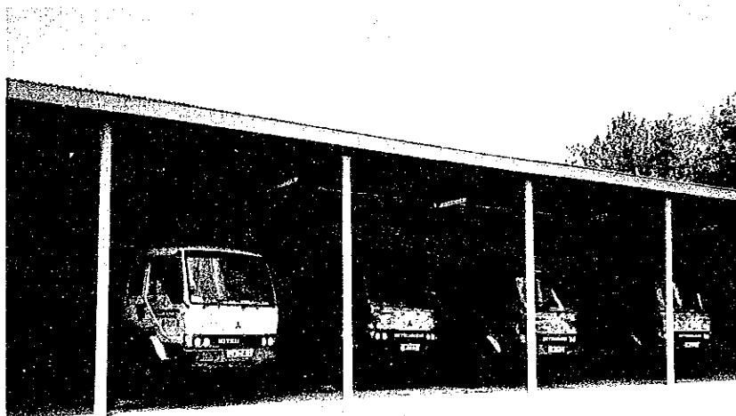
MOWTCフォートポータル 州土木工事事務所 修理工場および機材置場/ 日本の無償資金協力および第3次 道路計画により導入された車両
