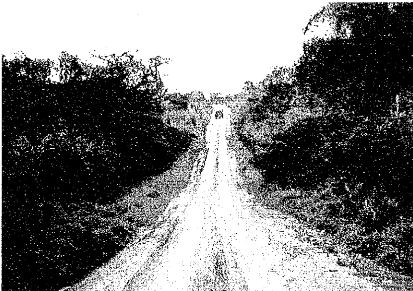
フォートポータル〜ムベンデ国道 ケンジョジョームベンデ区間 未整備区間
