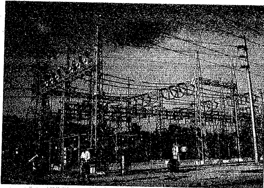
エスロサラド発電所 屋外変電所 230kV/138kV/69kV
