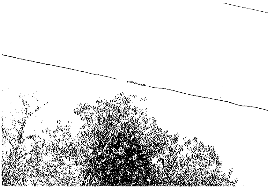
低圧電線の接続状態
