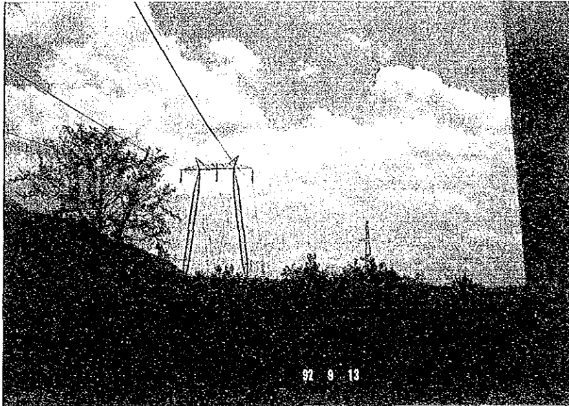
Kidatu-Morogoro -Dares Salaam 220kV送電線 Morogoro付近
