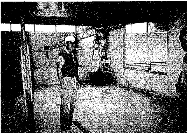
F 2、専門家の執務室の内装工事
