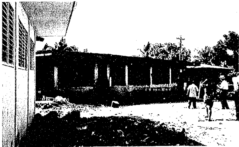
既存屠殺場外観 (市場増築敷地)
