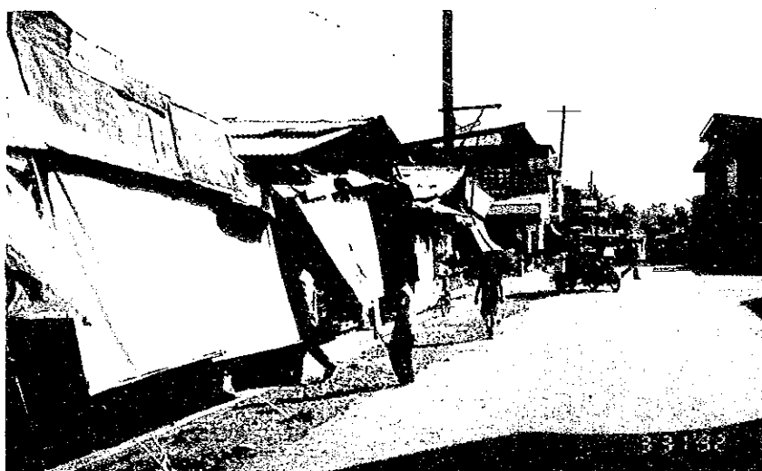
市場バラック群 (改修部分)
