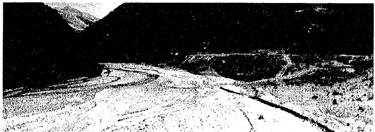
108km付近 土石流が堆積しているアルケ川
