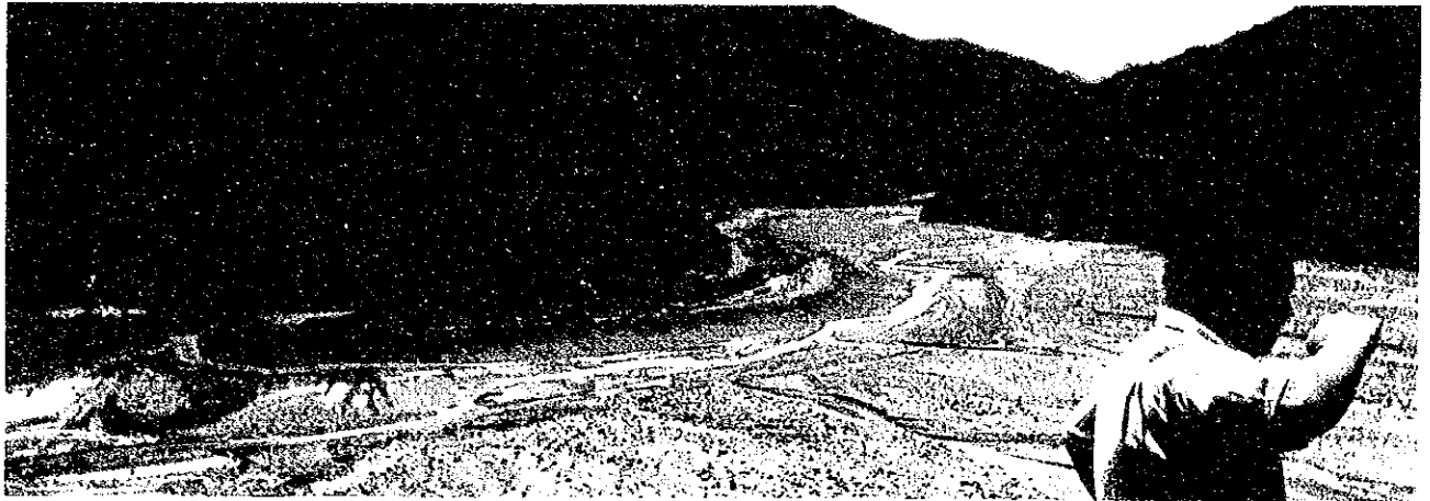
104km付近 ENFE で計画している新設長大橋（約500m）架設予定地点
