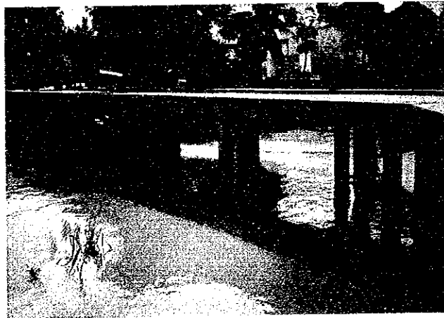
プノンペン港 バース4への渡橋
