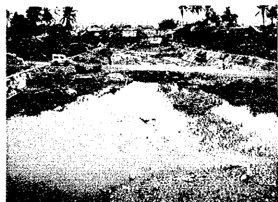
アニラオ川にかかる仮設道路 (オルモック市内)
