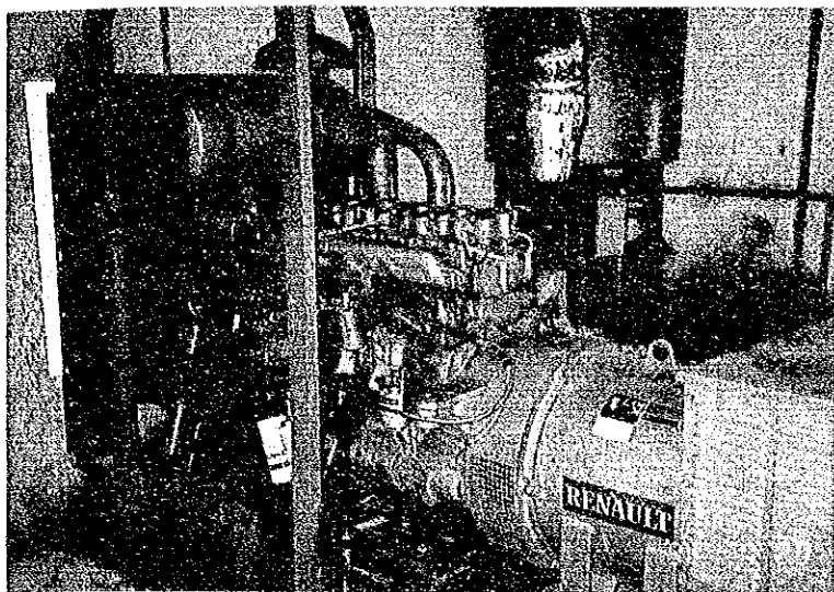
テビ灌漑区 排水機
