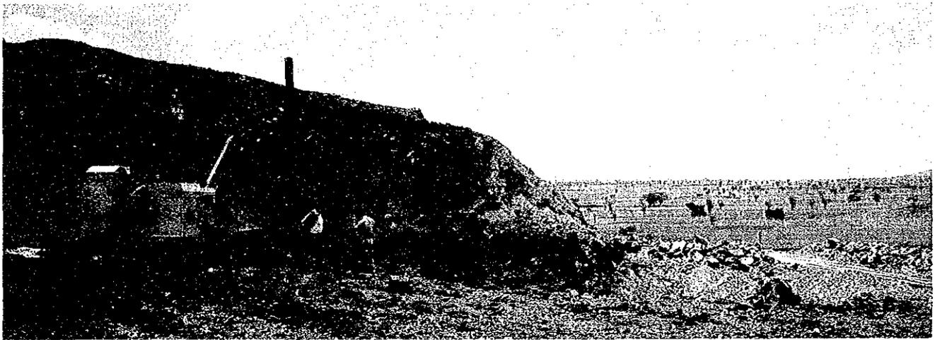
クローラドリルでさく岩し、ダイナマイトで爆発破碎して碎石砂利の原材料を採取する
