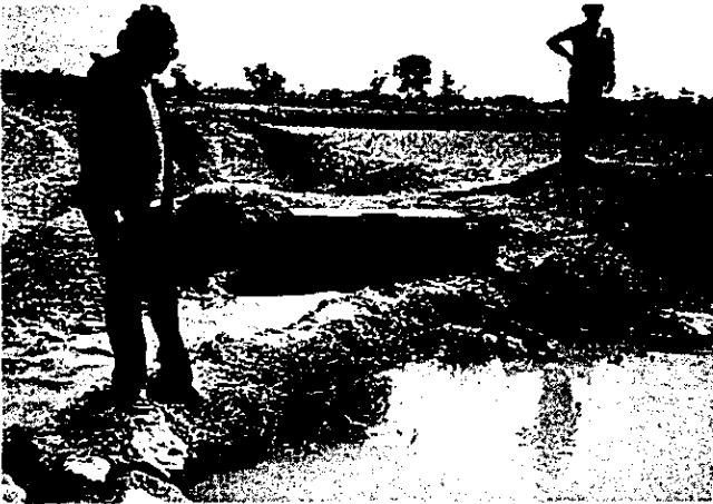
Minor からField Canal への取水 (土で堰上げをしている)
