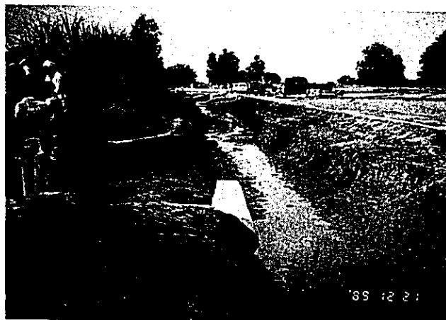
Distributry から Field Canalへの取水
