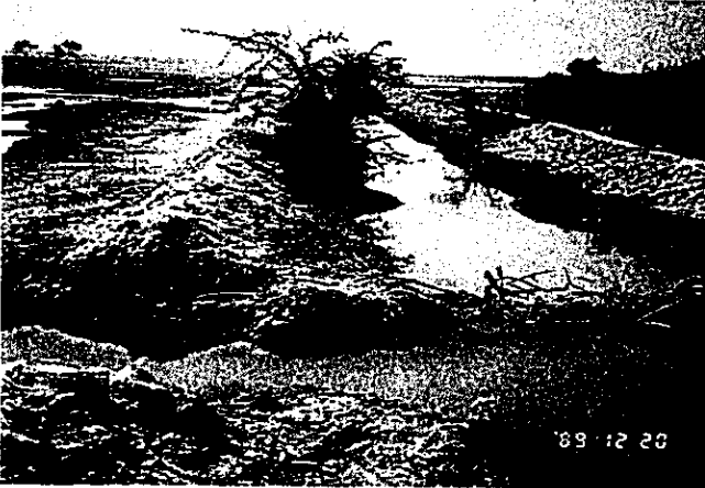
Minor からField へ直接取水 (Outlet及びField Canal は未完成)
