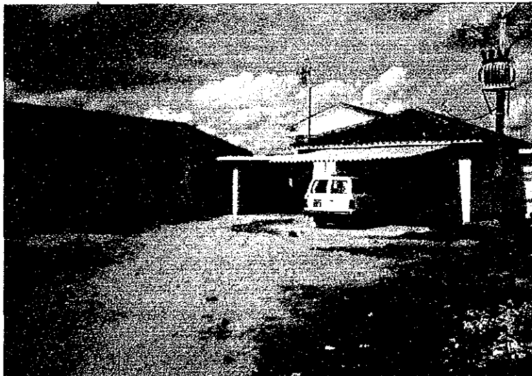
側方より X線室・臨床検査室 救急車置場を臨む
