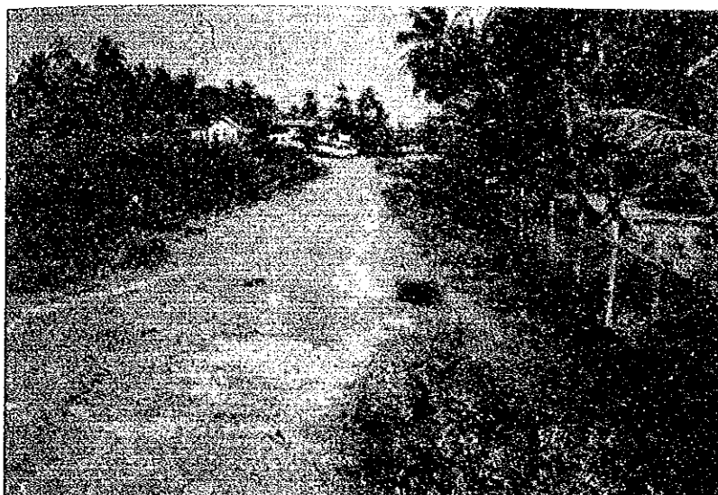
④ 当施設建設サイト予定地
