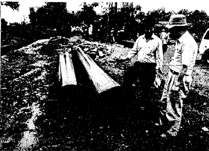
ケースド工法により掘削 中、玉石のため破損した ドライブ・ケーシング
