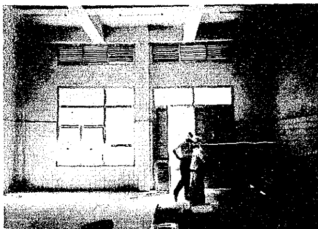
変電及び非常用発電機室内部
