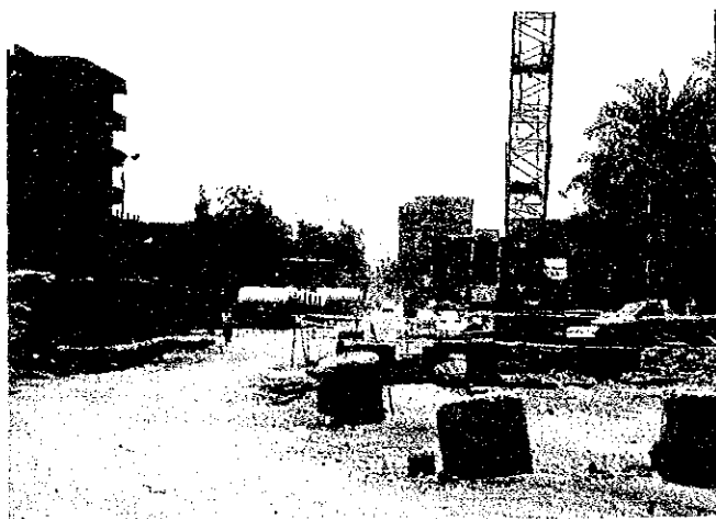
No.5(B)ポンプ場の吐出先となるUSAIDによる排水幹線を現在建設中 (No.5(B)ポンプ場入口付近)
