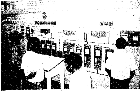
浄水場中央監視室
