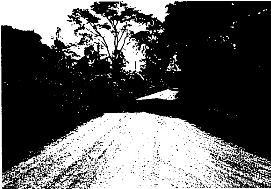
日本政府無償 供与機械で整備 された農村道路
