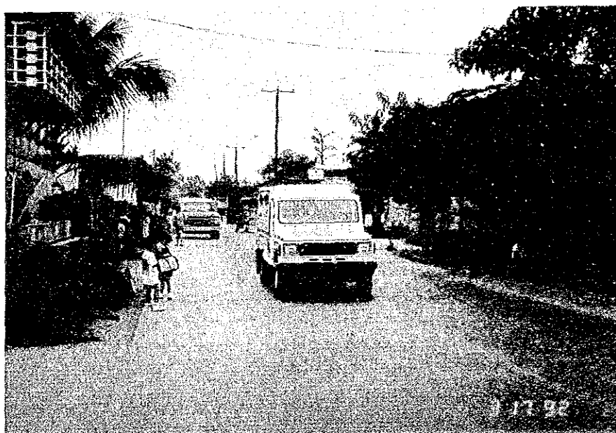
写真10-8 Ro/Ro ターミナルへの道路状況 (Bacolod 港) Source: JICA Study Team
