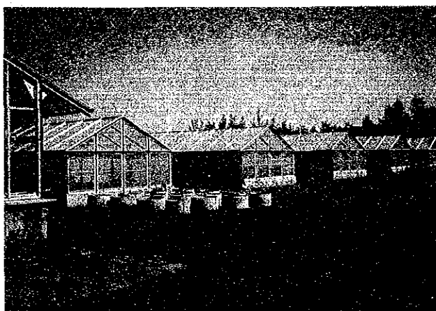
写真二 プロジェクト基盤整備事業により建設された網室 (CLGC)
