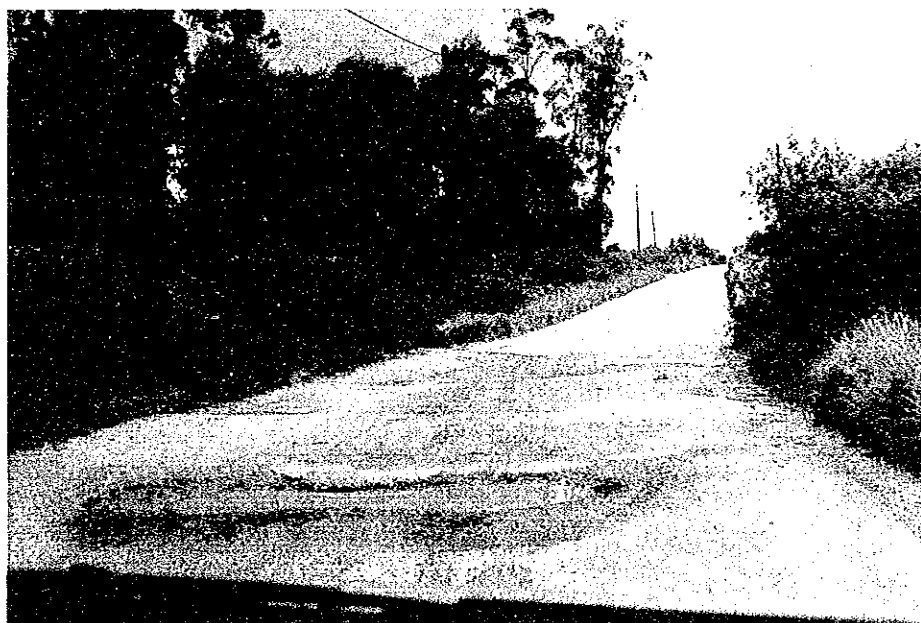
拡大したポットホール現状
