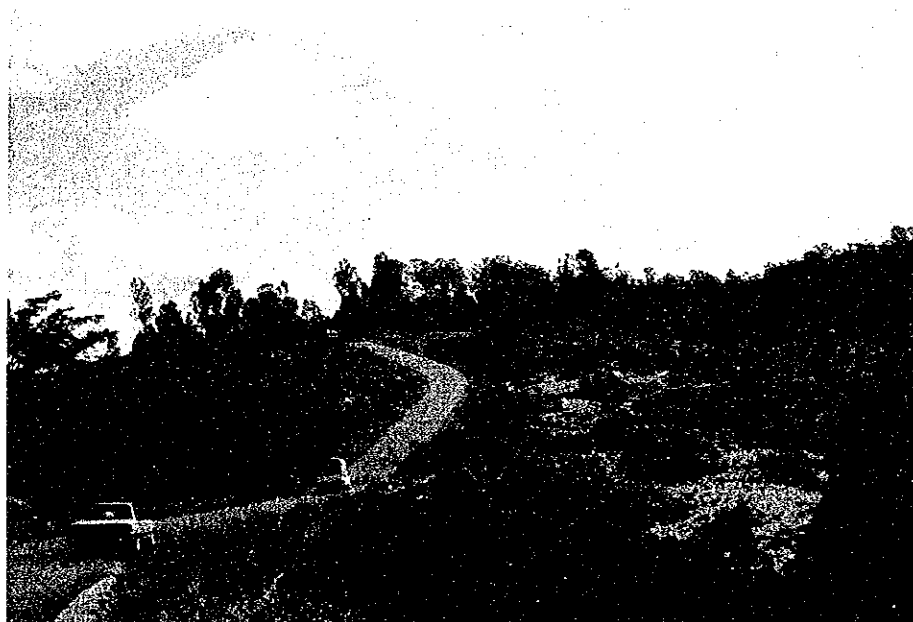
縦断線形の改良は行われていない
