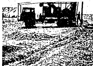
写真3) エチオピア北部、マカシ市郊外、干ばつ被災民のための地下水採取工事現場。7~25mに水脈があるという。
