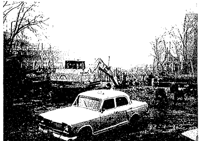
(写-6) 九江市—南昌市間高速道路 南昌市内の工事現場。徹夜3交代の夜間作業 を行っている。市街地の真中を通過している。
