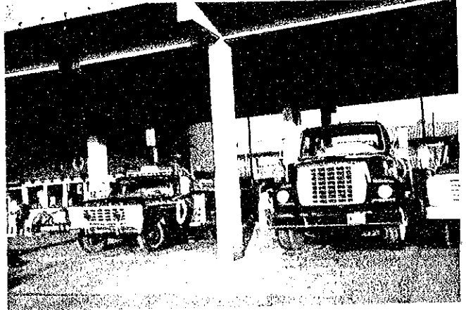
消防団本部車両収納状況
